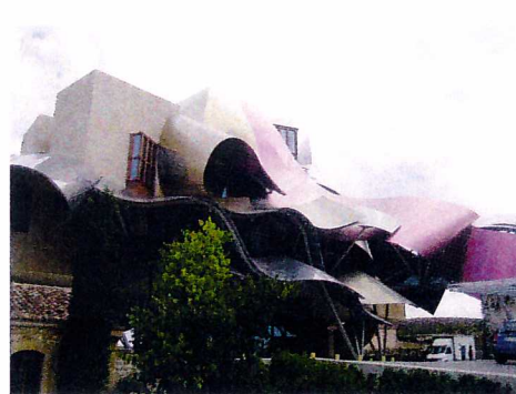
GEHRYS WERK Hotel-Restaurant bei Marqués de Riscal
